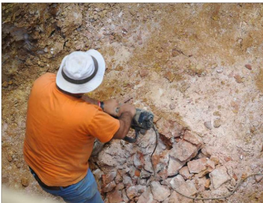
Trabajos con martillo neumático para retirar roca caliza bajo el puente de Elefante. ECB
